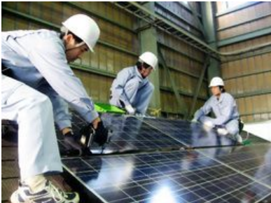
太陽光パネルの設置研修を受ける受講生たち＝埼玉県川口市の太陽光発電工事専門校の研修所
